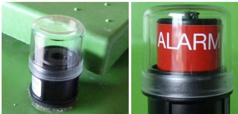
Son fonctionnement est des plus simple ; il ne requiert donc aucun entretien quotidien particulier. C'est pourquoi il n'y a qu'un seul indicateur sur votre filtre, placé à côté de l'un des tampons d'accès. Il vire au rouge en cas de niveau d'eau anormal à l'intérieur du massif filtrant Seta (le niveau d'eau fait monter un flotteur en bas de cuve, relié par une tige au voyant rouge d'alarme). Le cas échéant, veuillez contacter votre Partenaire exclusif Tricel local.
